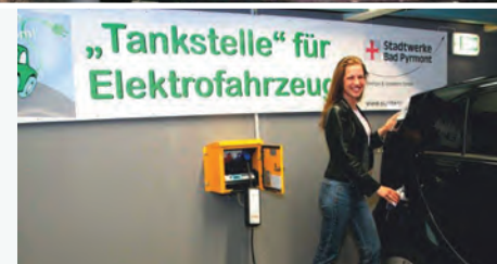
Parkhaus Bad Pyrmont
